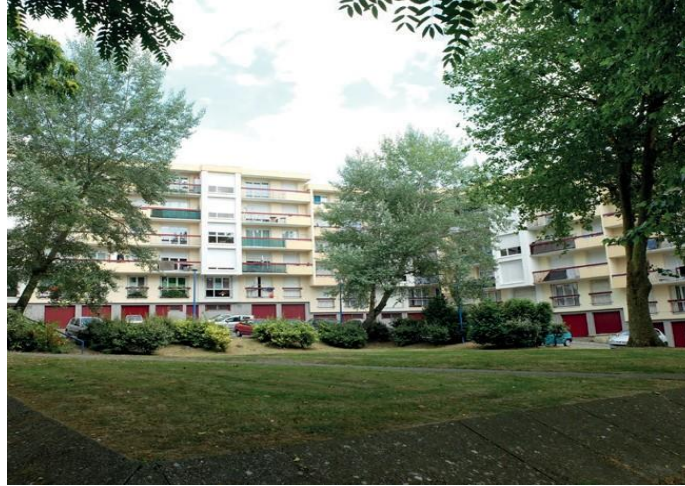
Espace peu aménagé et utilisé
