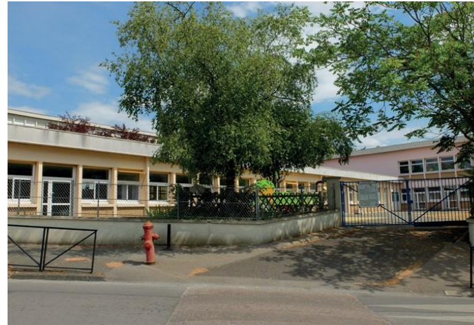
Accès à la maternelle Decour 1
