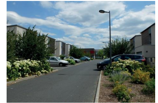
Construction de l'Orée des Champs
