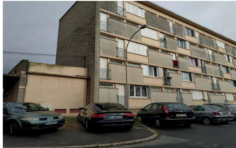
Le stationnement anarchique derrière 50 Anatole France
